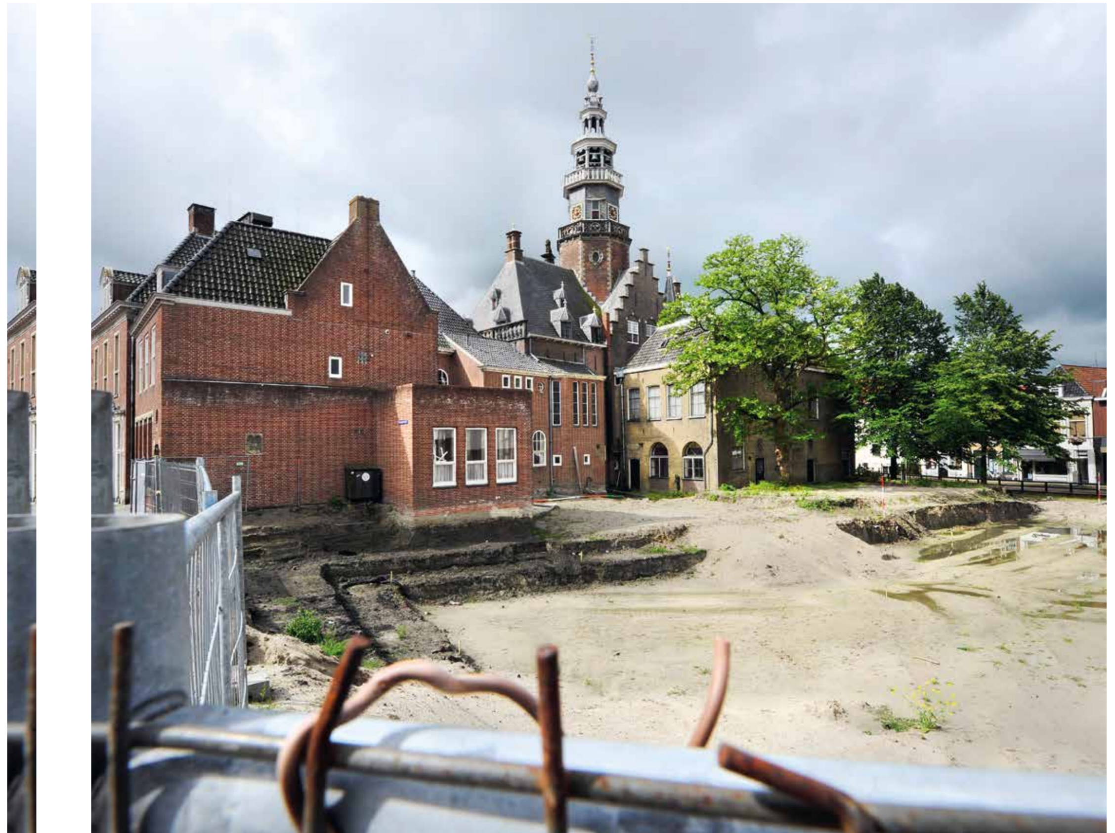
De bouwput voor het gloednieuwe museumdepot en atrium ligt achter het stadhuis. Links de secretarie en rechts het voormalige waaggebouw. Foto's: Alex J. de Haan
